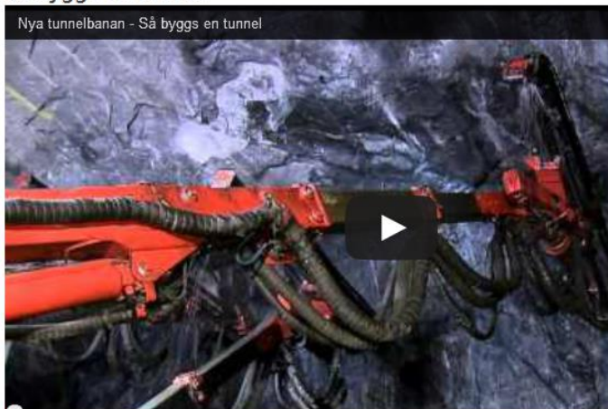
Så byggs en tunnel
